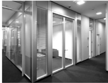
Das Standardachsmaß beträgt 1000 mm. Doppelschalige Verglasung aus SIGLA® Verbund-Sicherheitsglas 8 und 10 mm oder 10 und 12 mm.
