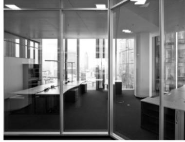
Die Rahmensichtbreite ist mit nur  $2 \times 13$  mm auf ein Minimum reduziert. Mit einer Fuge von 6 mm ergibt sich insgesamt eine Pfostenbreite im Wandsystem von nur 32 mm. Die Wandstärke beträgt 100 mm, das Standardachsmaß 1000 mm. Doppelschalige Verglasung aus DELODUR® Einscheiben-Sicherheitsglas 6 und 8 mm. Die Ganzglaswand bietet geprüfte Schalldämmwerte bis  $R_w = 46$  dB sowie die Feuerwiderstandsklasse F30.
