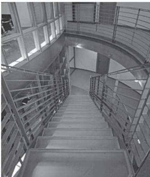
Bei der rutschhemmenden Oberfläche handelt es sich um ein spezielles Email mit rauher Oberfläche auf ESG oder auf teilvorgespanntem Glas, das fest in die Glasoberfläche eingebraunt ist. Dieses Email entspricht in etwa der Verschleißklasse II bis III nach DIN 154, (Widerstand gegen Oberflächenverschleiß), und ist damit nicht für hochfrequentierte Bereiche geeignet.
